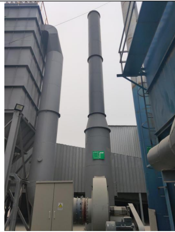
二号搅拌机组热再生处除尘器及排气筒
