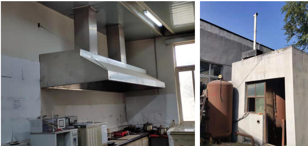
图 11 实验室废气净化设施及排气筒
