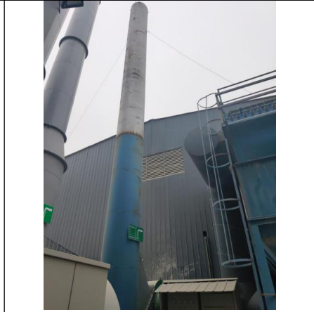
二号搅拌机组上料处除尘器及排气筒
