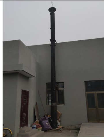
沥青存储罐区废气净化设施及排气筒
