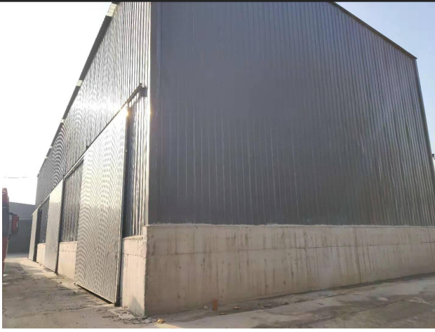
冷再生破碎筛分系统防尘降噪封闭改造
