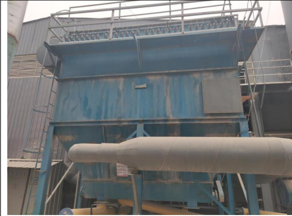
二号搅拌机组上料处除尘器及排气筒
