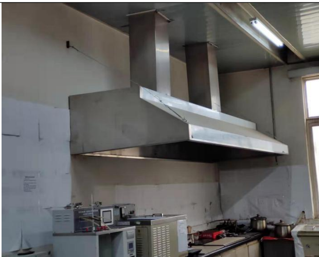
实验室废气净化设施及排气筒
