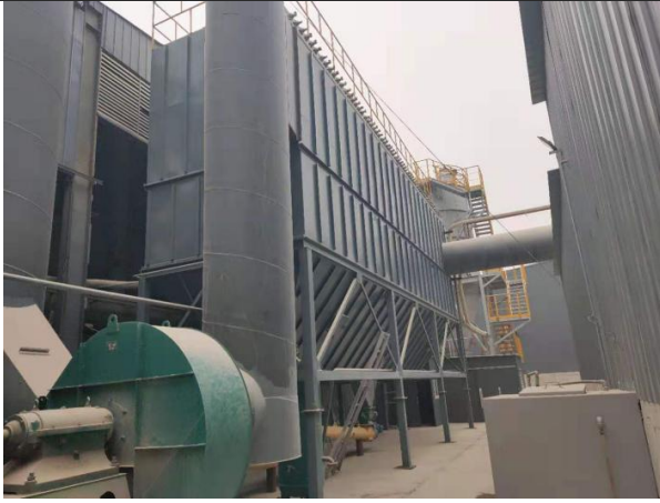
沥青存储罐区废气净化设施及排气筒
