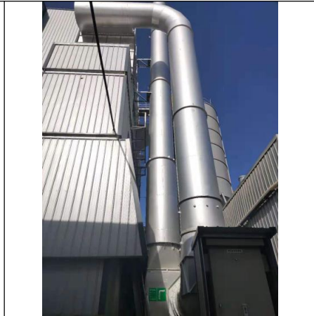
二号搅拌机组上料处除尘器及排气筒
