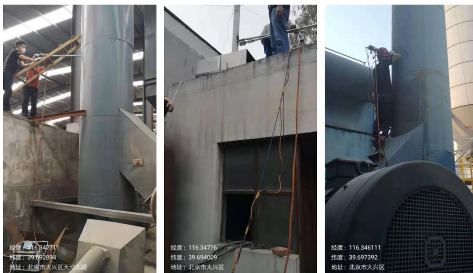
图 15 现场监测照片
