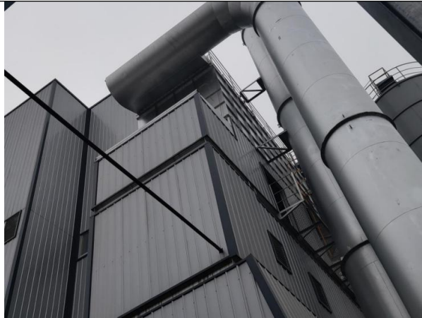
二号搅拌机组上料处除尘器及排气筒
