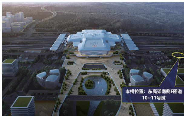
b) 长沙高铁西站东高架匝道桥
