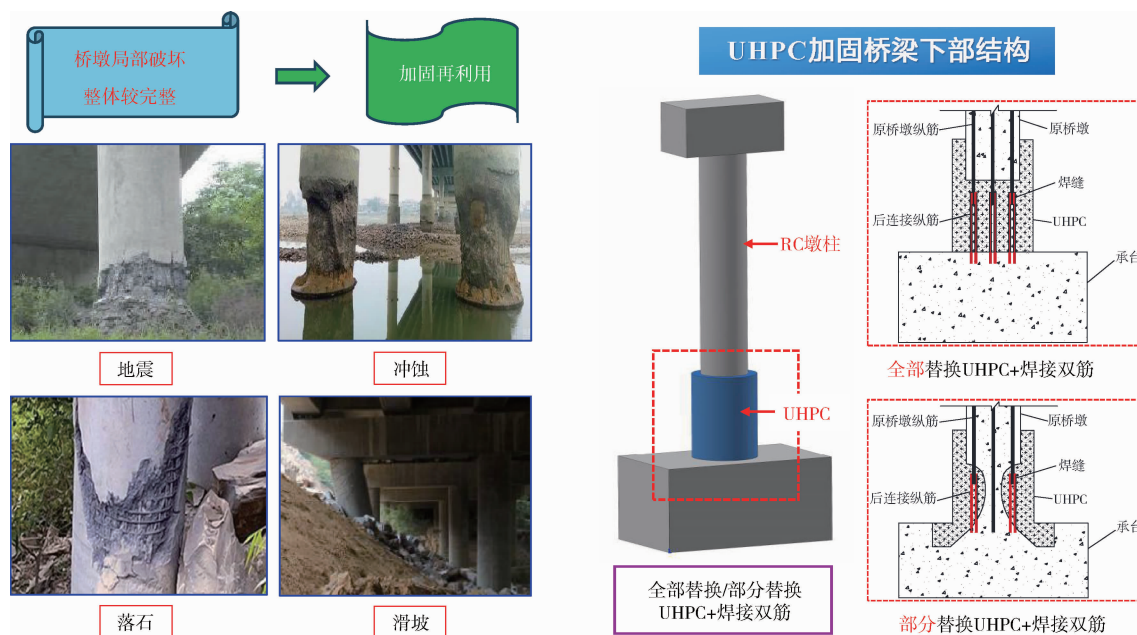
图7 UHPC 加固桥墩
