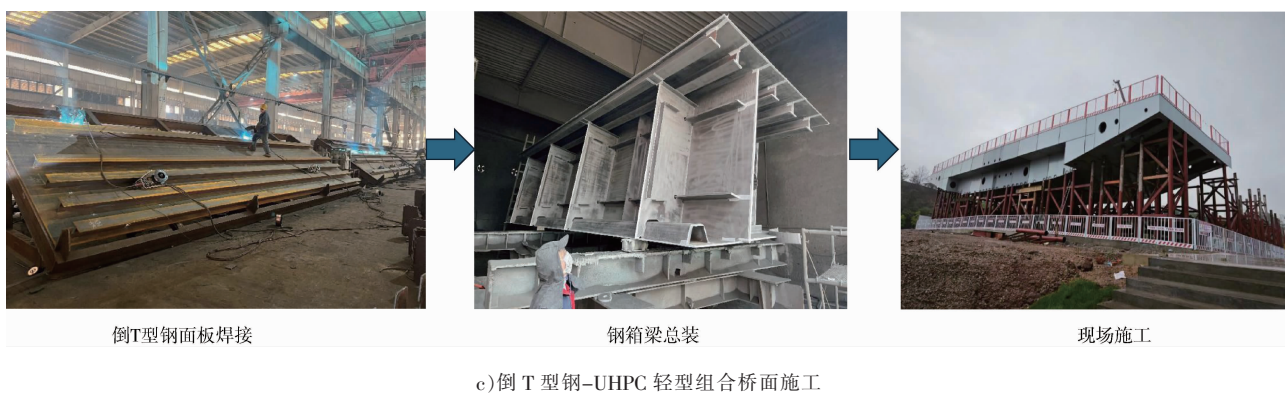
图4 倒T型钢-UHPC 轻型组合桥面结构及其工程应用
