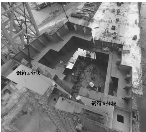
图 4 索塔钢箱节段分块吊装图
